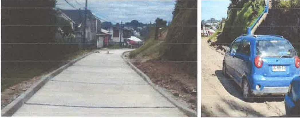
Mejoramiento Pasaje La Cantera
