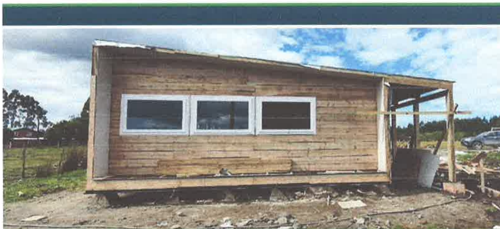
Construcción Sede Social Club Deportivo Estrella Blanca – Caulin La Cumbre
