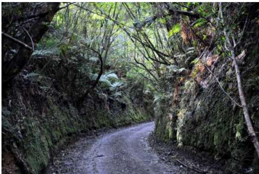
Camino vehicular rural sobre antiguo trazado de la ruta del tren Ancud – Castro, sector Puntra. ©Pablo Villegas
