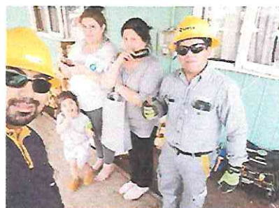
Instalación Generador cliente Doña Adelina Vargas Ruíz, sector Guabun.
