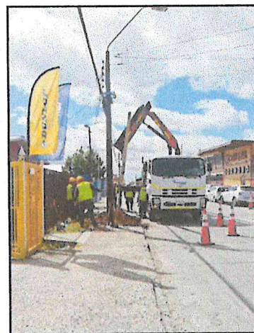
Trabajos de Mantenimiento Calle Arturo Prat
