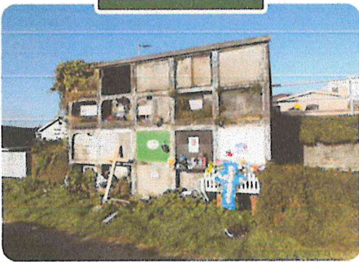
Estado actual · Nicho Municipal · Cementerio de Ancud
